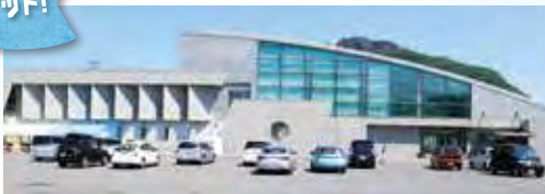
国道230号沿いにある 豊滝除雪ステーション
