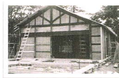
復元中「旧棟・通行屋」(昭和60年)
