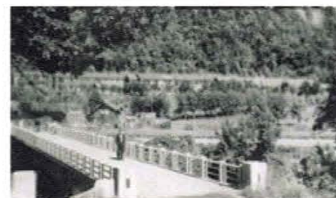
3. 御料橋からの病院棟 (昭和35)
